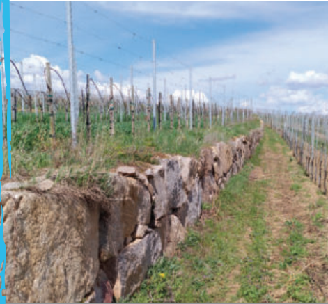
Muret en pierres sèches. © Arthur Keller
